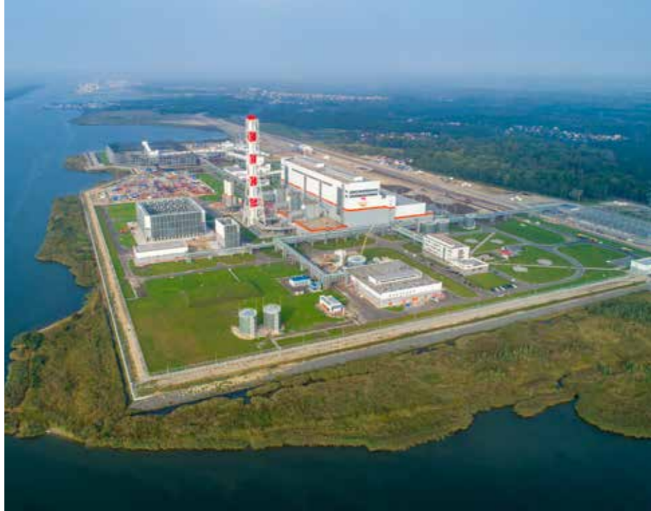
Приморская ТЭС, Калининградская область Источник: www.utz.ru
